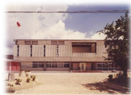
昭和44年7月 竣工時の図書館
