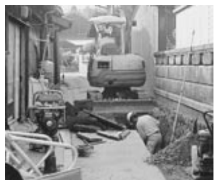
西浦町地内下水道工事
