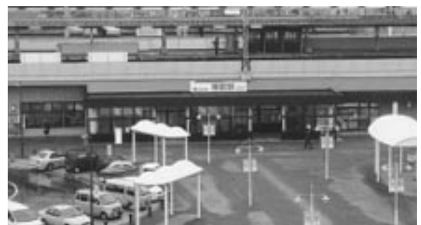
整備の進む蒲郡駅
