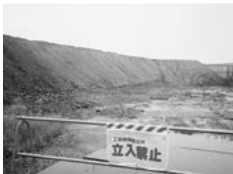
新消防庁舎建設用地
