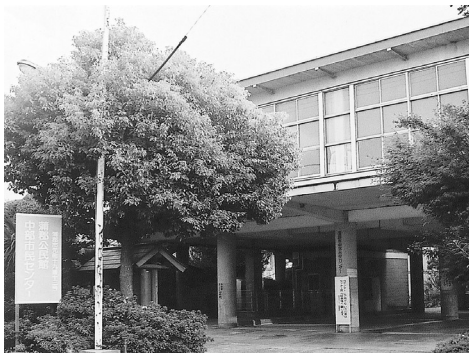
蒲郡公民館（中部市民センター）
