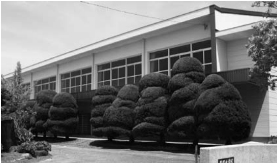
耐震工事を行った蒲郡中学校体育館
