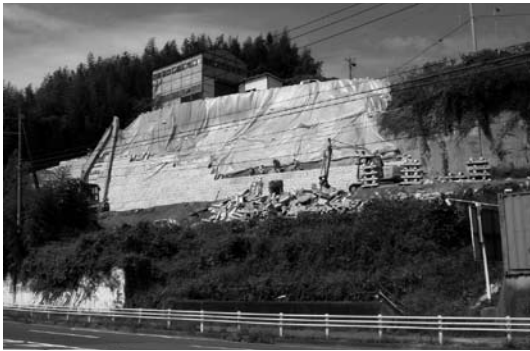
集中豪雨によるがけ崩れ（23号線）
