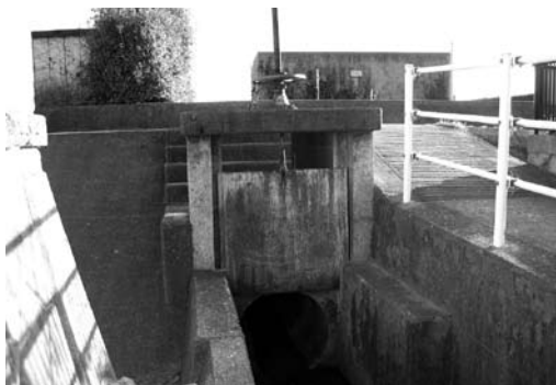
宮川河口樋門
