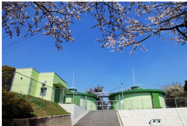
蒲郡市配水池
