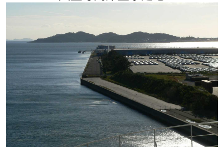
大型専用岸壁予定地
