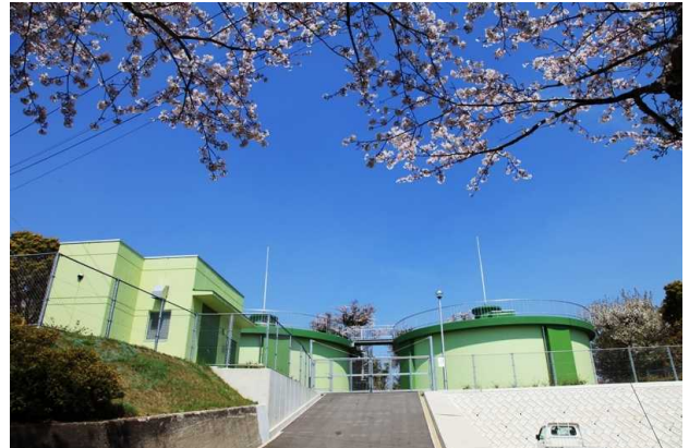
蒲郡市配水池
