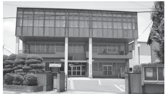
廃止された西部市民センター
