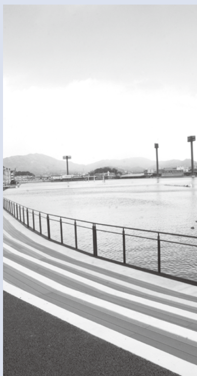
水しぶきがかかりそうな迫力でレースが楽しめます。
