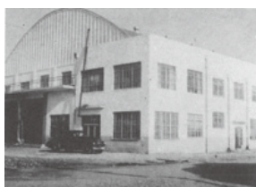
市役所(旧中央公民館)
