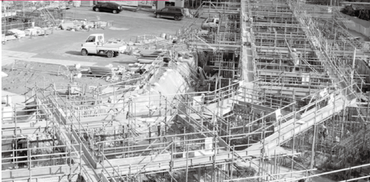
↑南三陸町内の災害住宅建設現場。(左上完成イメージ) 施設は高齢者や子育て層が安心して使えるような計画になっている。今年夏完成予定。
