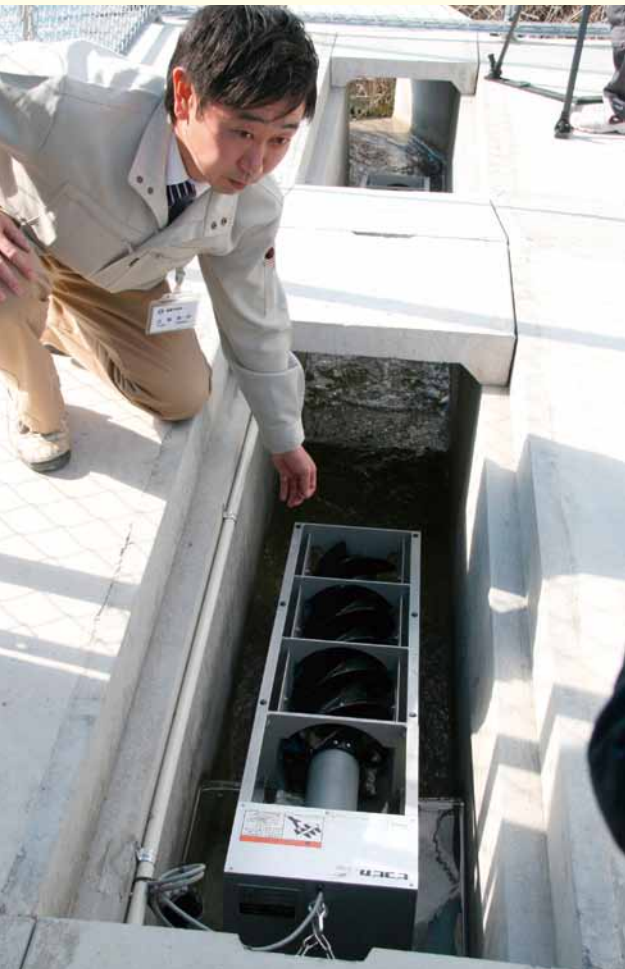
▲自然エネルギー小水力発電設備を設置（2月4日） 清田町の農業用水を利用し、小水力発電設備を設置。大内揚水機場の照明や非常時の電源として活用されます。
