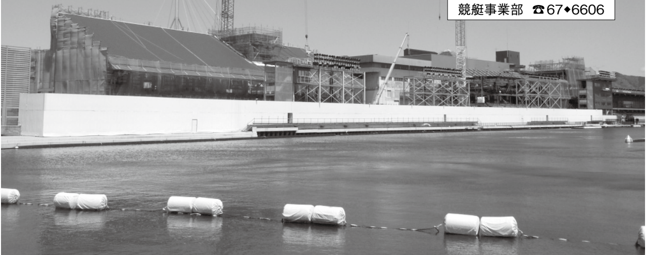
現在の改善工事の様子 (5月1日現在)
