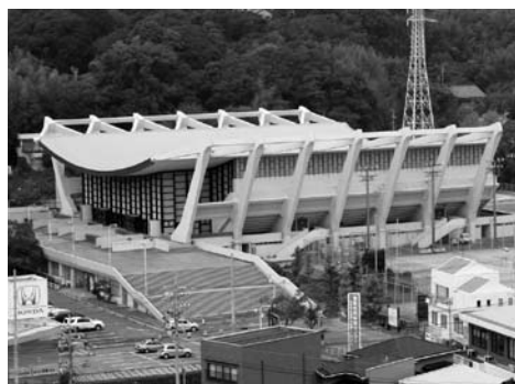
老朽化が進む公共施設（写真は昭和43年に建設された市民体育センター・競技場）
