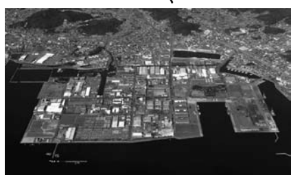
海洋産出試験の支援基地として利用されている蒲郡港
