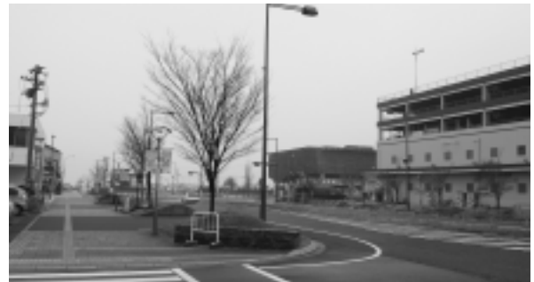
無電柱化を実施した県道蒲郡港線
