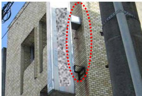
外壁との取付部の腐食
