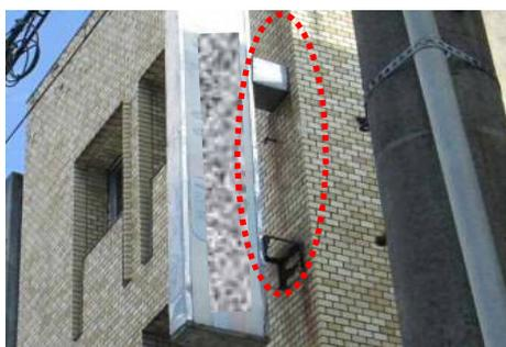
外壁との取付部の腐食
