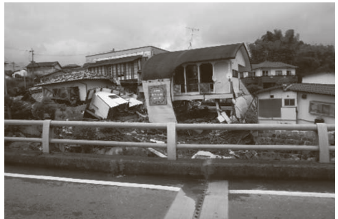
地盤ごと崩れた店舗(熊本県益城町)
