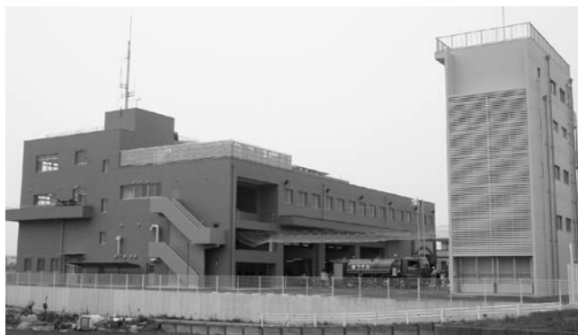
▲完成した新消防庁舎
