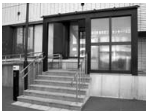
移設場所の市役所西出入口（休日市役所窓口センター）
