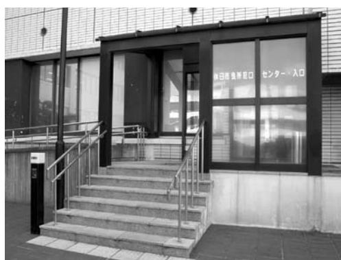
移設場所の市役所西出入口（休日市役所窓口センター）
