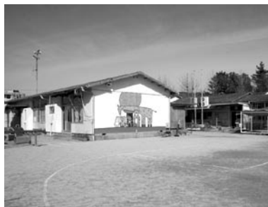
改修を予定している南部保育園
