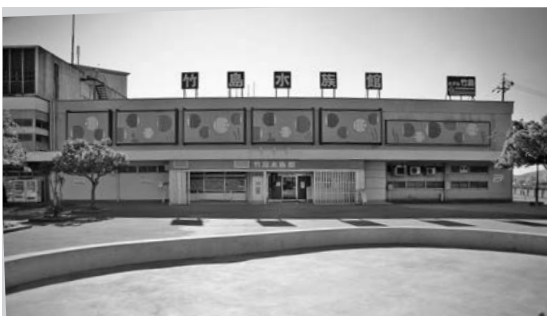
耐震改修・リニューアル工を行う竹島水族館
