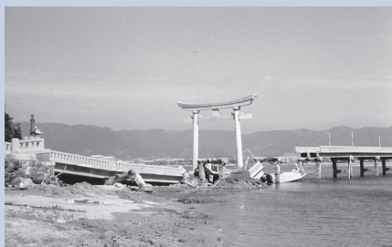
伊勢湾台風で崩れた竹島橋
