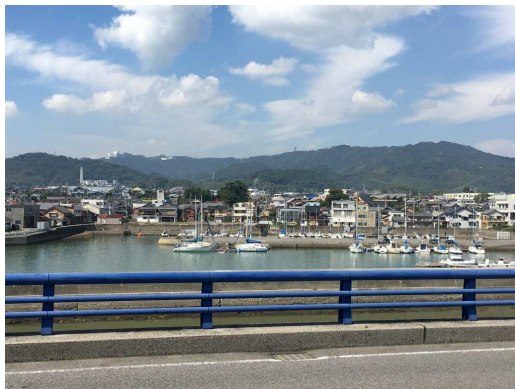
形原漁港大橋から見る船溜まり
