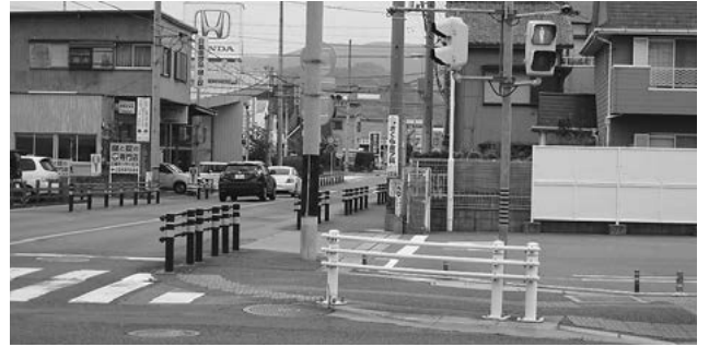
交差点に設置された防護柵
