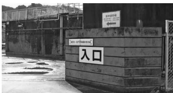
一色不燃物最終処分場
