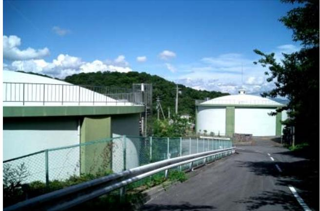
送配水方法は、水の位置エネルギーを利用した自然流下方式を用いていますが、一部標高の高い地域に対してはポンプ圧送方式を用いています。また、県水受水池から遠方に位置している施設には、残留塩素濃度が低下するため、塩素消毒設備を設置しています。
