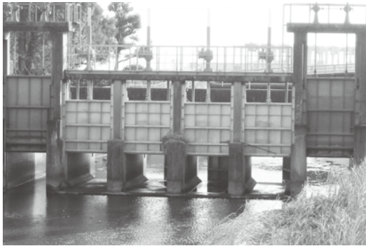
落合防潮樋門
