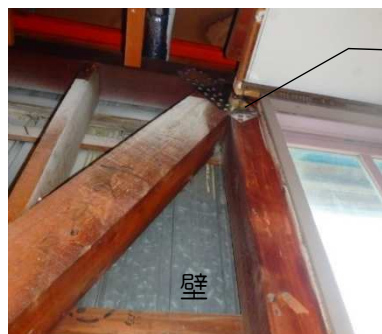
耐震補強工事 施工例
