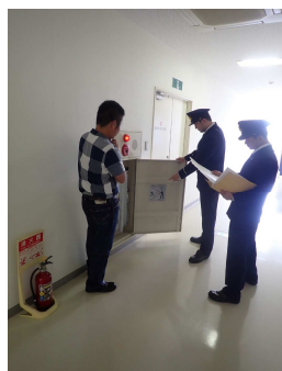
防火対象物の立入検査
