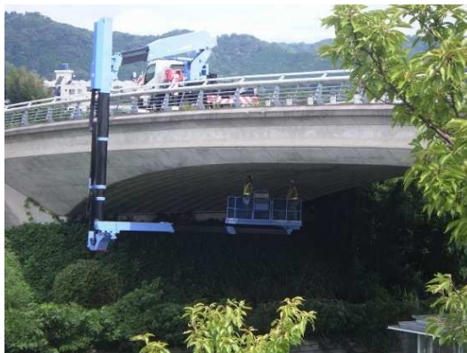
橋梁の定期点検
