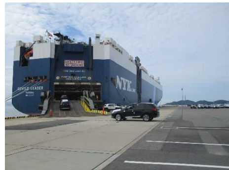
大型船用岸壁
