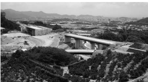
現在、完成に向け工事を進める国道23号
