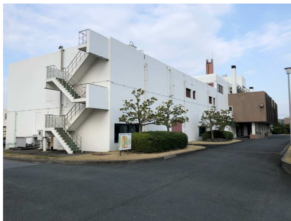
蒲郡市下水道浄化センター
