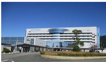
蒲郡市民病院の外観
