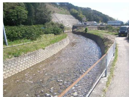
堆積土砂撤去後
