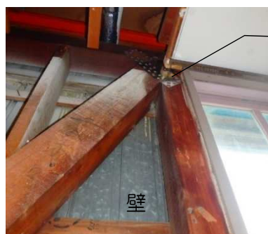
耐震補強工事 施工例
