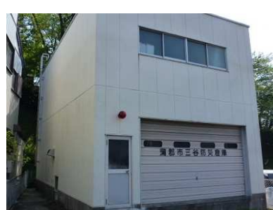
三谷防災倉庫
