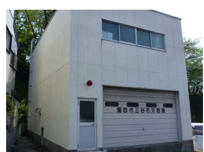
三谷防災倉庫
