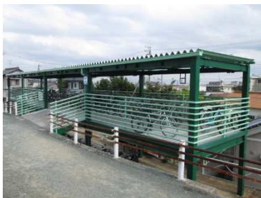
大塚駅第1自転車駐車場
