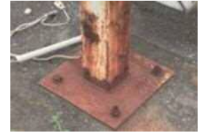
鉄骨のさび・塗装の老朽化
