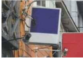
上部構造全体の傾斜、ぐらつき
