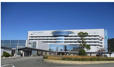
蒲郡市民病院の外観
