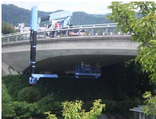
橋梁の定期点検
