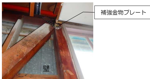
耐震補強工事 施工例
