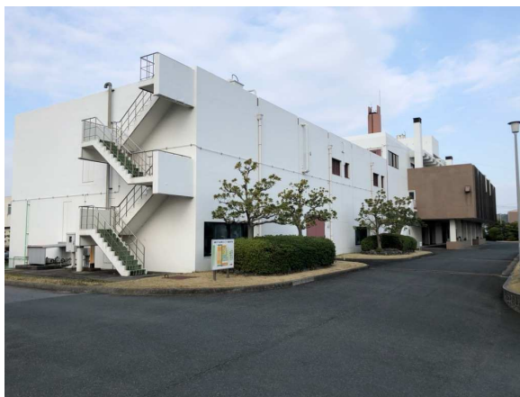
蒲郡市下水道浄化センター
