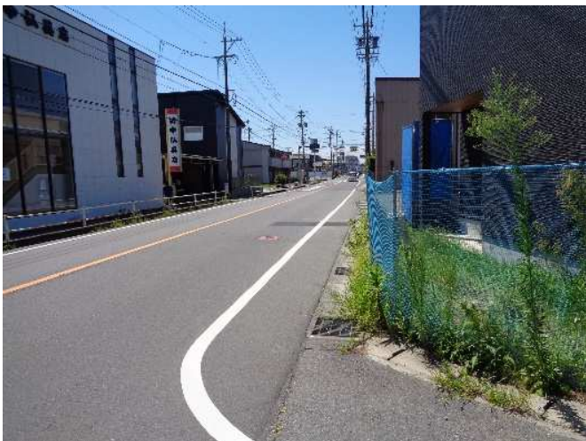
道路外側線の整備
