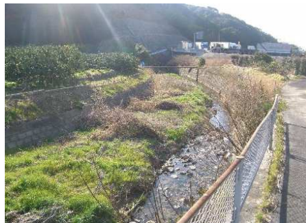
堆積土砂撤去前
