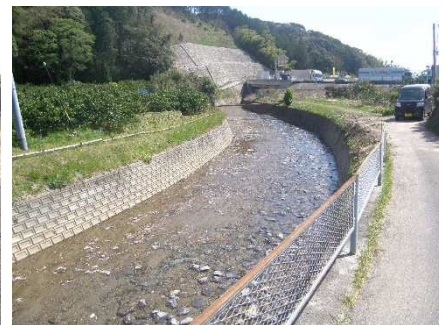
堆積土砂撤去後
