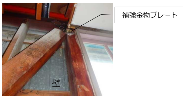
耐震補強工事 施工例
