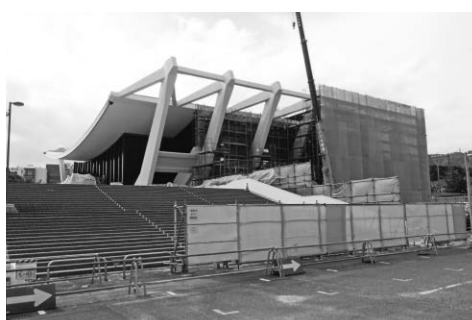
工事中の市民体育館
