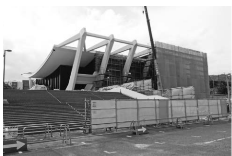
工事中の市民体育館
