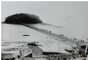
弁天大祭の竹島仮橋(明治38年) [蒲都市博物館 蔵] (12年ごとの巳年の大開帳にあわせて架けられた木製仮設橋)
