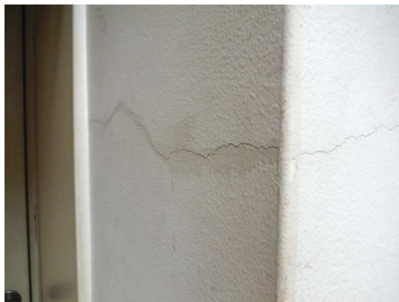
壁に入った亀裂
