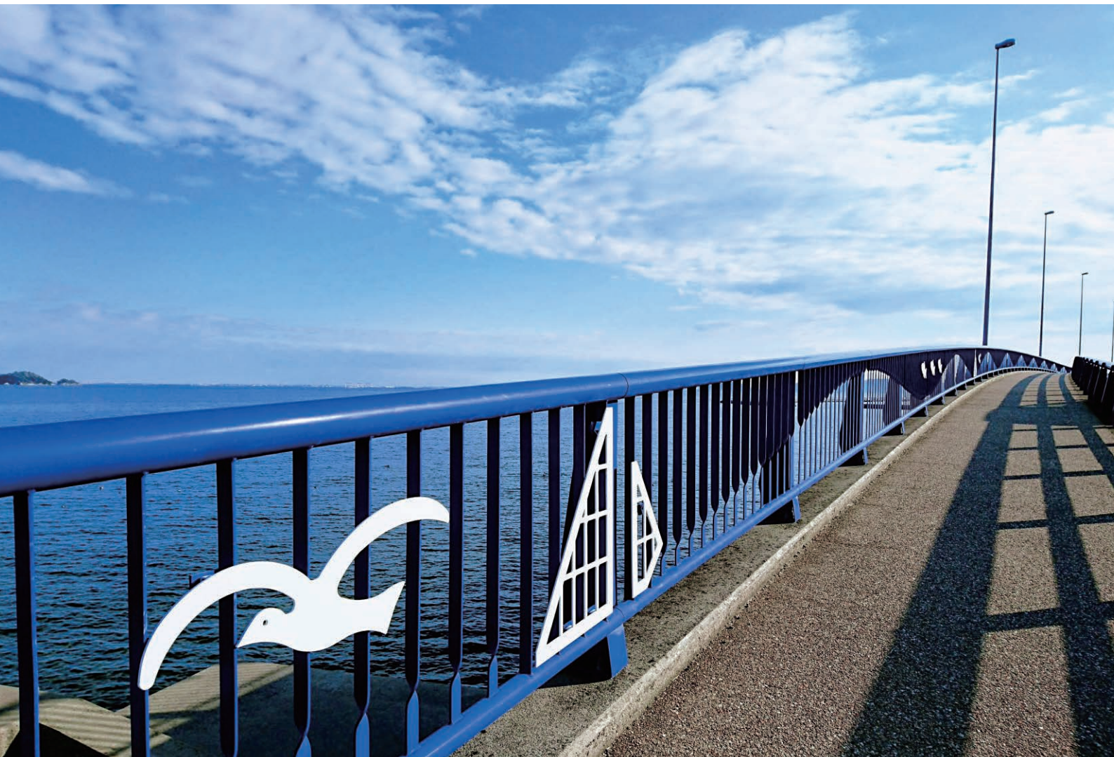
形原漁港大橋（ブルーブリッジ）
