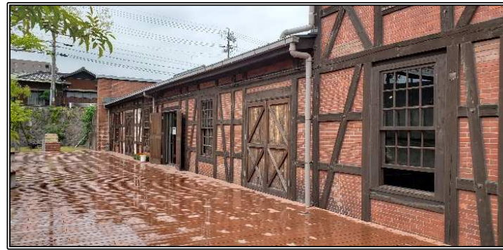
半田赤レンガ建物(半田市)
