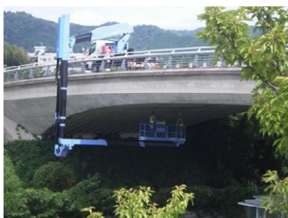
橋梁の定期点検
