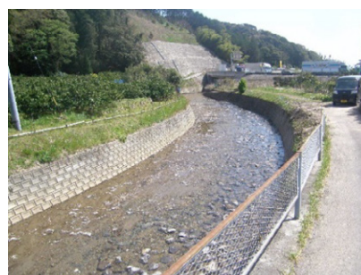
堆積土砂撤去後
