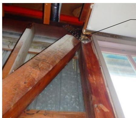
耐震補強工事 施工例
