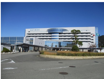
蒲郡市民病院の外観
