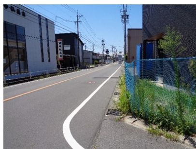
道路外側線の整備
