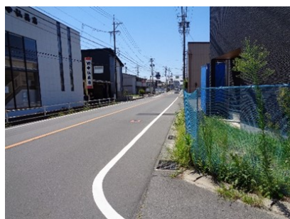
道路外側線の整備
