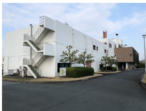
蒲郡市下水道浄化センター
