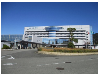
蒲郡市民病院の外観
