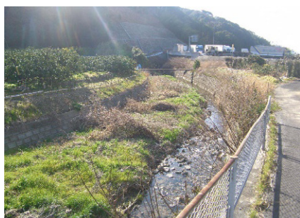
堆積土砂撤去前
