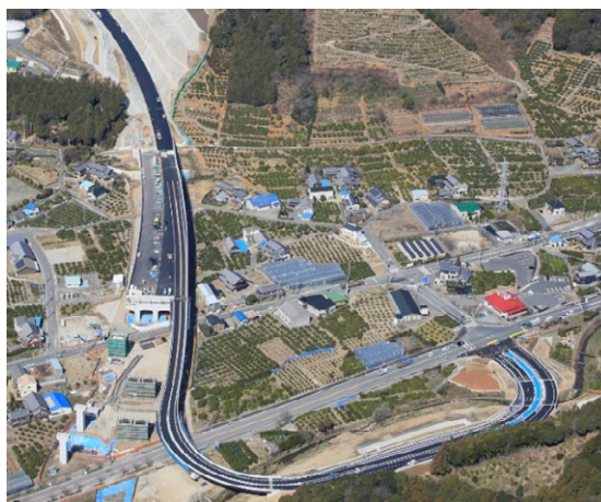
国道23号蒲郡バイパス 蒲郡ICから名古屋方面を望む
