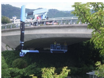
橋梁の定期点検
