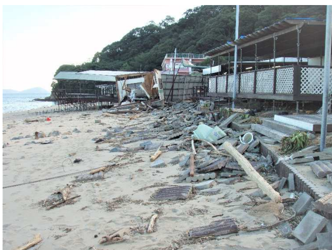
平成 30 (2018) 年 台風 24 号による大島の被害
